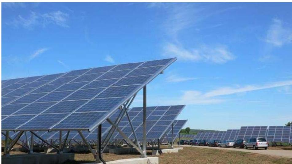
图 5.2-1 固定式安装方式
